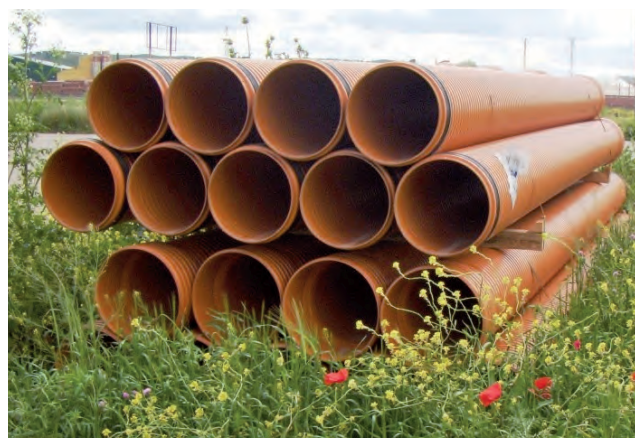
ACOPIO TUBERÍA SANECOR®.
