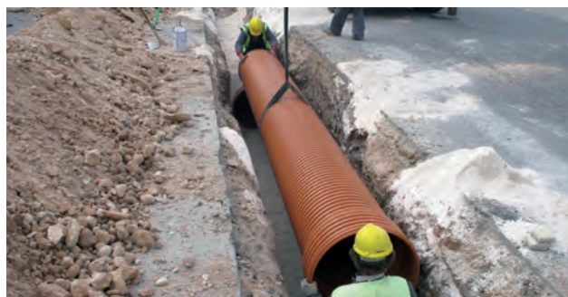
MANIPULACIÓN EN OBRA DEL TUBO SANECOR®.
