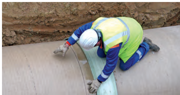
UNIÓN POR MANGUITO EN TUBERÍAS DE PRFV DE GRAN DIÁMETRO.
