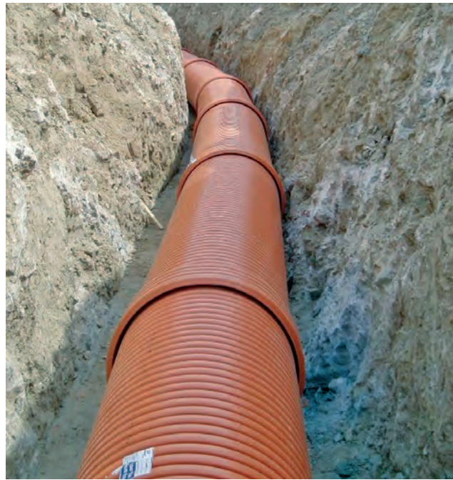
TUBERÍA SANECOR® DE 1200 mm CON DESVIACIÓN ANGULAR.
