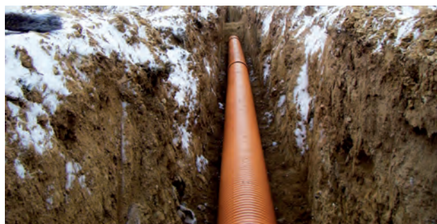
VISTA DE TUBERÍA SANECOR® INSTALADA EN LA ZANJA.
