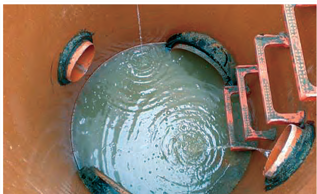
REALIZACIÓN DE MÚLTIPLES ACOMETIDAS REALIZADAS IN SITU.
