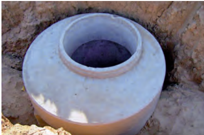
POZOS DE REGISTRO EN MATERIALES CONVENCIONALES (HORMIGÓN Y LADRILLO). A LA DERECHA, ANILLOS PREFABRICADOS DE HORMIGÓN.
