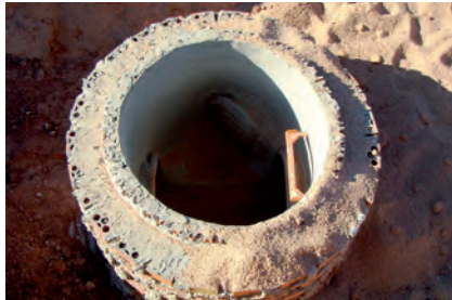
POZOS DE REGISTRO EN MATERIALES CONVENCIONALES (HORMIGÓN Y LADRILLO). A LA DERECHA, ANILLOS PREFABRICADOS DE HORMIGÓN.
