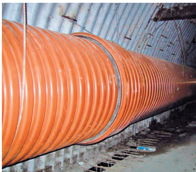
INSTALACIÓN DE TUBERÍAS SANECOR® EN GALERÍA Y EN ZANJA.
