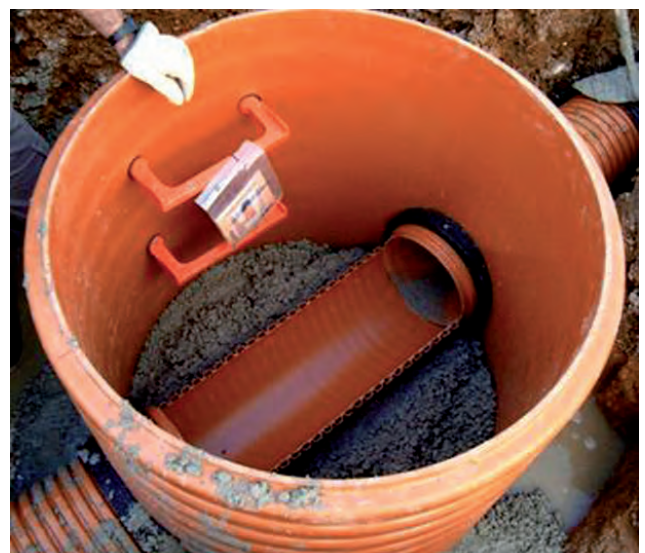
HORMIGONADO DEL FONDO DEL POZO. 2ª FASE.
