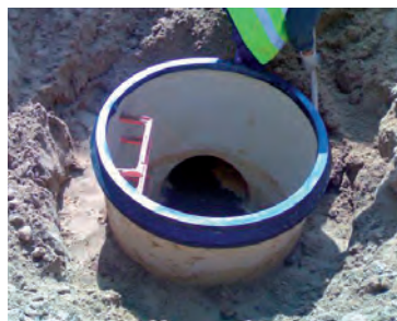
POZOS DE REGISTRO EN MATERIALES PLÁSTICOS (POLIÉSTER Y POLIETILENO).
