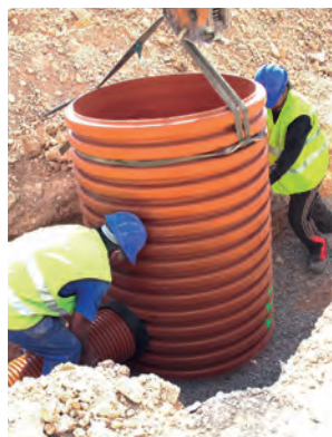
INSTALACIÓN DE TUBERÍAS AL CUERPO DEL POZO.
