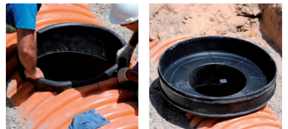
INSTALACIÓN DEL CUERPO CON BASE DE REGISTRO.
