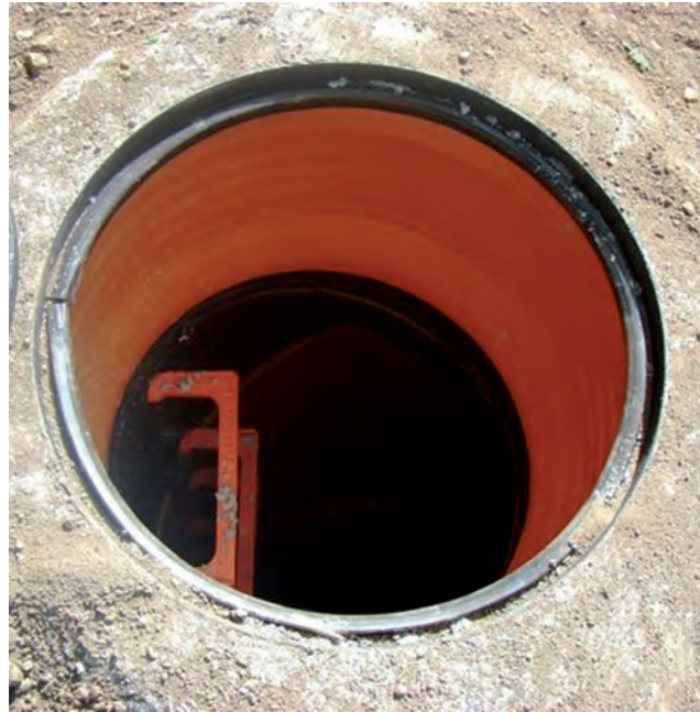
CORONACIÓN DEL POZO.
