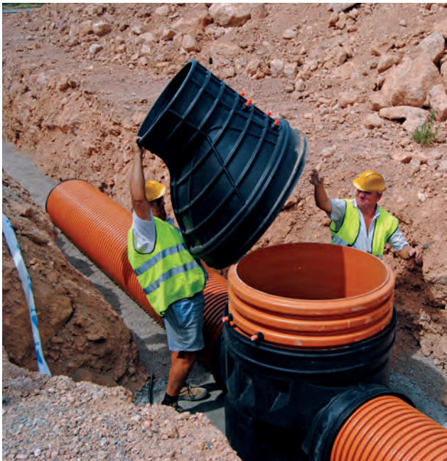
INSTALACIÓN DE PIEZA ENTRONQUE DE PASO TOTAL.
