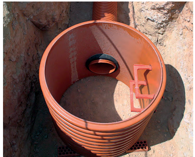
HORMIGONADO DEL FONDO DEL POZO. 1ª FASE.
