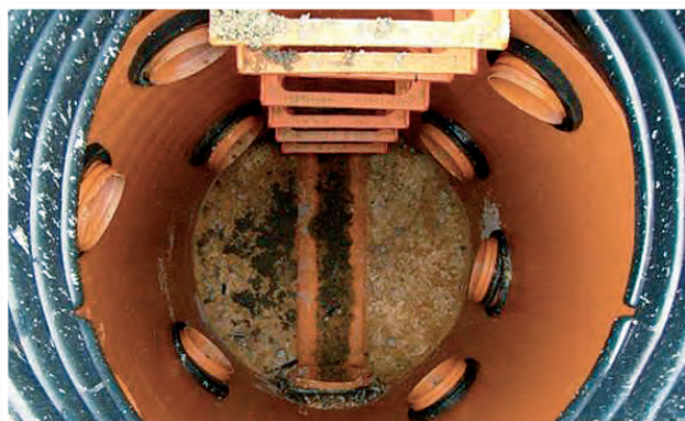
REALIZACIÓN DE MÚLTIPLES ACOMETIDAS REALIZADAS IN SITU.
