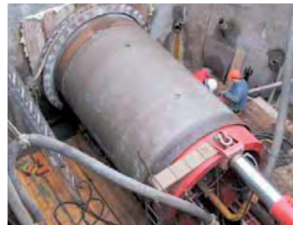
Hormigón polímero (tuberías de hinca).
