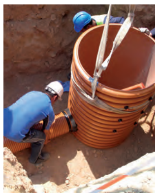
INSTALACIÓN DE TUBERÍAS AL CUERPO DEL POZO.
