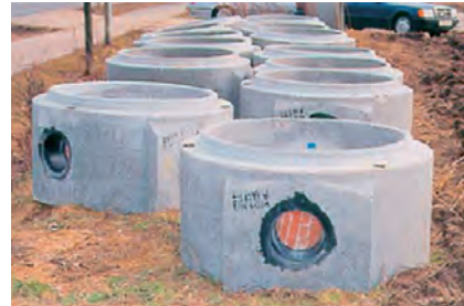
POZOS DE REGISTRO EN MATERIALES CONVENCIONALES (HORMIGÓN Y LADRILLO). A LA DERECHA, ANILLOS PREFABRICADOS DE HORMIGÓN.
