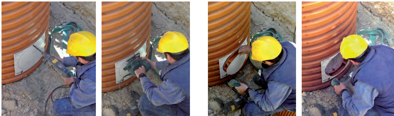
PROCEDIMIENTO DE PERFORACIÓN DE TALADROS PARA INSERCIÓN DE CLIPS ELASTOMÉRICOS.
