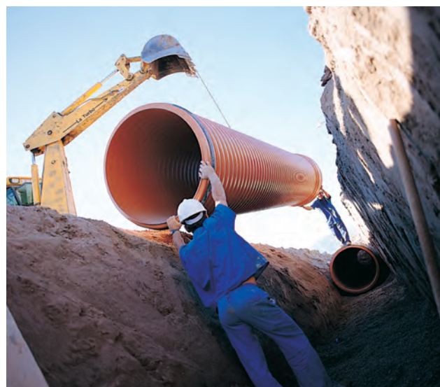
INSTALACIÓN DE TUBERÍAS SANECOR® EN GALERÍA Y EN ZANJA.
