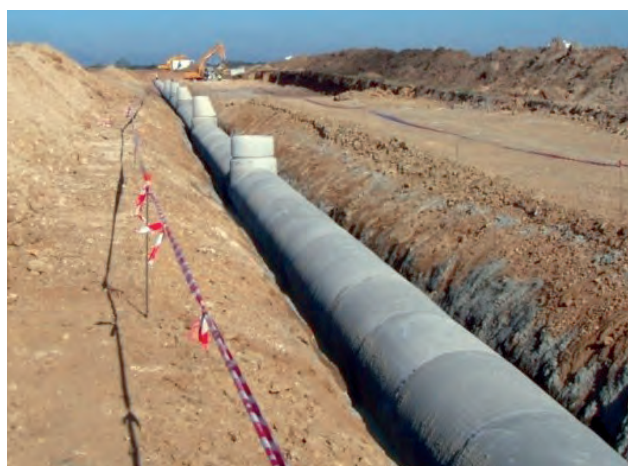
COLECTOR DE HORMIGÓN ARMADO.
