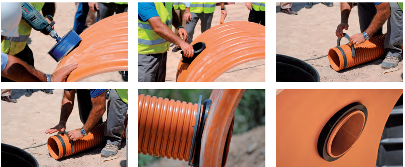
SECUENCIA DE MONTAJE DE PIEZA “DIADEMA” PARA EL TOPE DE LAS ACOMETIDAS SANECOR®.
