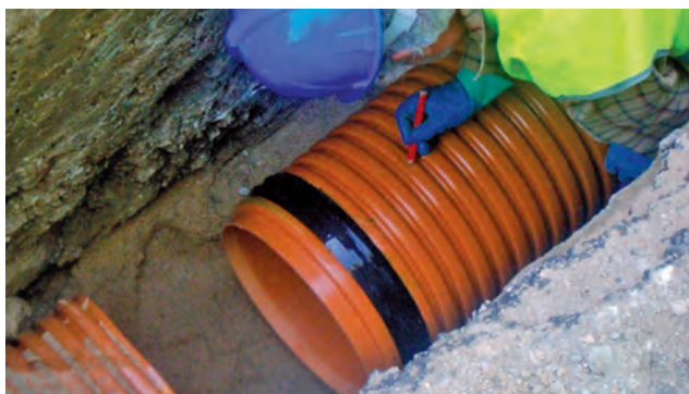
CONEXIÓN MANUAL DE TUBERÍA CORRUGADA.
