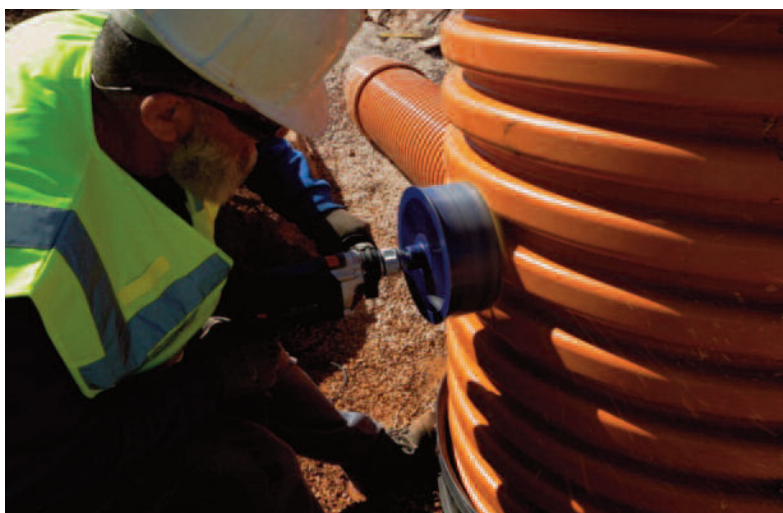
Realización de una acometida con corona de corte
