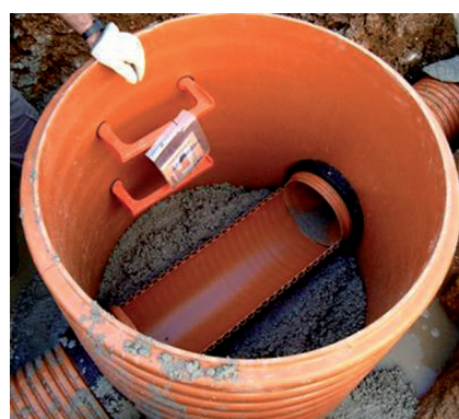
Acabado interior de un pozo a 180°
