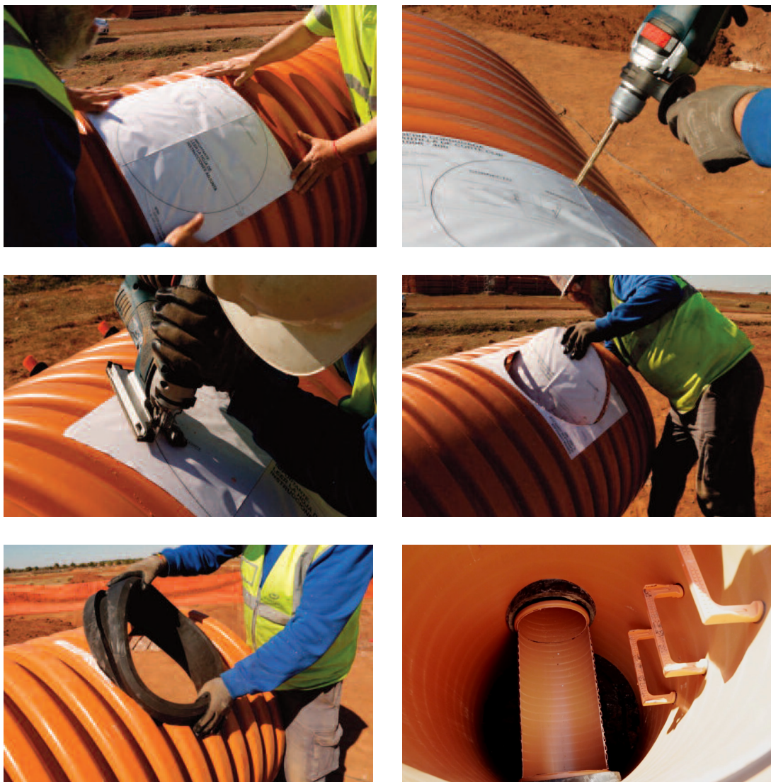
Secuencia de instalación de un clip elastomérico
