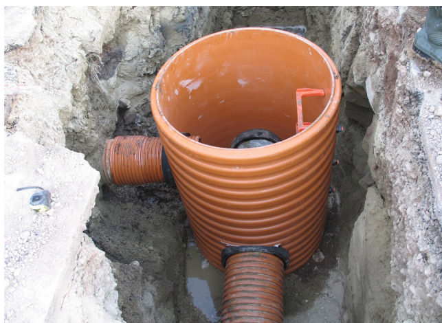
Ejecución de acometidas realizadas in situ
