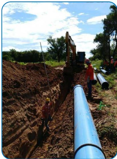
En total se han instalado más de **172 km de tubería de PVC-O TOM®** y más de **200 accesorios ecoFITOM®** entre las que se incluyen **codos de 45°, codos de 22,5°, manguitos y reducciones de todos los diámetros** fabricados por Molecor.
