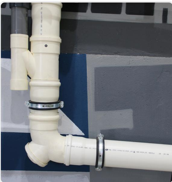
**Las columnas de ventilación deben mantener el mismo diámetro en toda su altura.** Por el extremo superior se pueden unir a la bajante por encima de la cota del último aparato sanitario o bien salir al exterior atravesando la cubierta. **Por el extremo inferior puede** enlazarse a la bajante por debajo del último ramal o **conectarse directamente a los colectores**, considerándose esta segunda opción como más idónea, siendo esta conexión al colector a una distancia, como máximo, de 10 veces.
