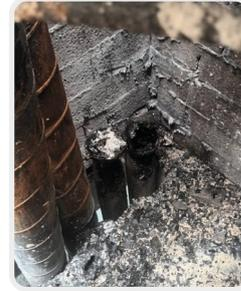
Vista cercana de las montantes afectadas, se puede comprobar la expansión hacia el interior impidiendo la propagación del humo y con la parte exterior solamente ennegrecida por el fuego.
