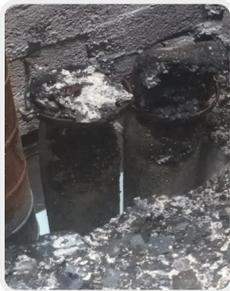
Vista de otra montante afectada que ha cerrado por completo el tubo instalado.
