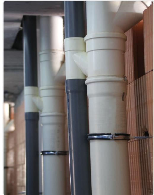
**Molecor** ha diseñado la pieza para ventilación, compuesta por un tubo de bajante de 110 mm y un tubo de ventilación de 63 mm, con columnas de uniones para cada planta.
