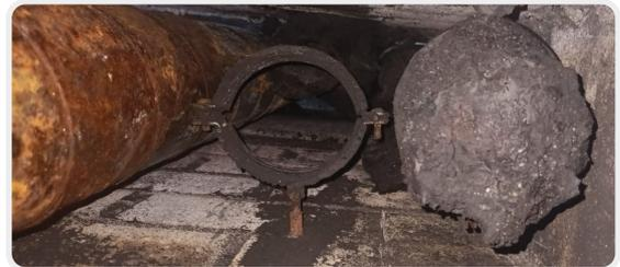
Montantes en la planta inmediatamente inferior que no se han visto afectadas al no propagar el incendio el Sistema AR® por partículas o gotas inflamadas.
