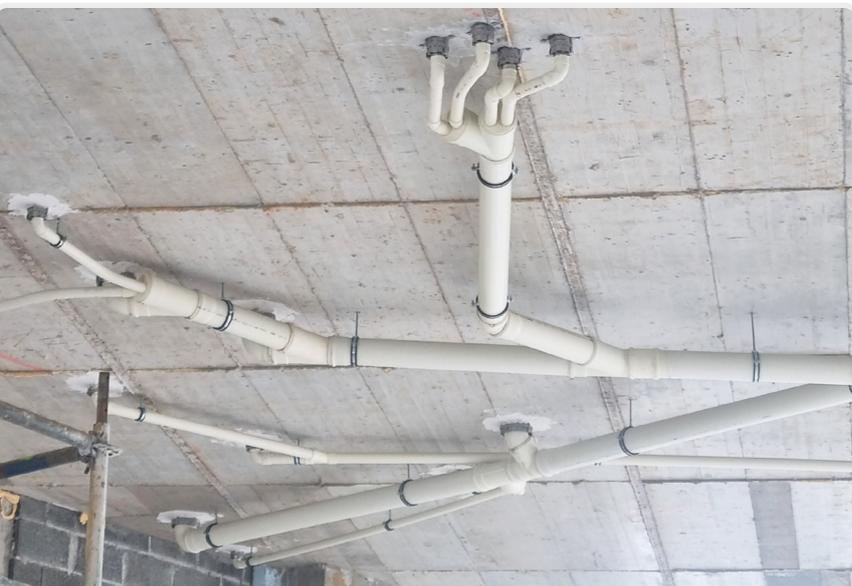
La marca **NF Me** francesa certifica la capacidad de expansión mínima del 800% de la pared del tubo o del accesorio hacia su interior, midiendo la tasa de expansión del material, al ser sometido a altas temperaturas producidas en un incendio. Dicha expansión, contribuye a taponar las bajantes, impidiendo el paso del humo entre compartimentos.
