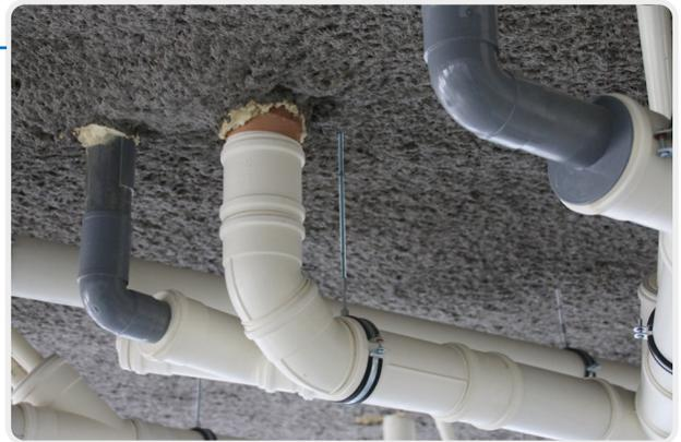
La ventilación consiste en la colocación de una tubería en paralelo a la bajante interconexionada con ésta, de forma que cumple el propósito de prevenir el desarrollo de depresiones excesivas, particularmente en la parte inferior de la bajante, permitiendo que el aire comprimido en la base de la columna encuentre una salida.
