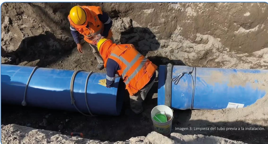
Imagen 3: Limpieza del tubo previa a la instalación.
